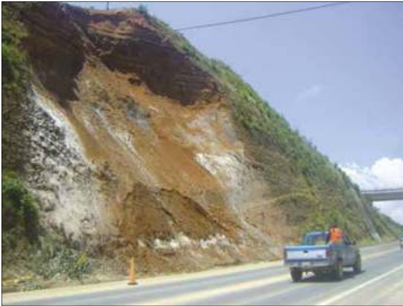
Figura 3. Deslizamiento en el Kilómetro 115 de la autopista Puebla-Teziutlán (foto: Alejandro Galindo).
