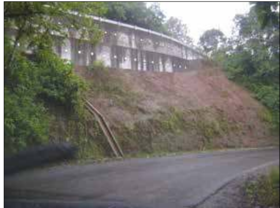
Figura 14. Muro de contención en el km 4 del Ramal a Hueytamalco.
