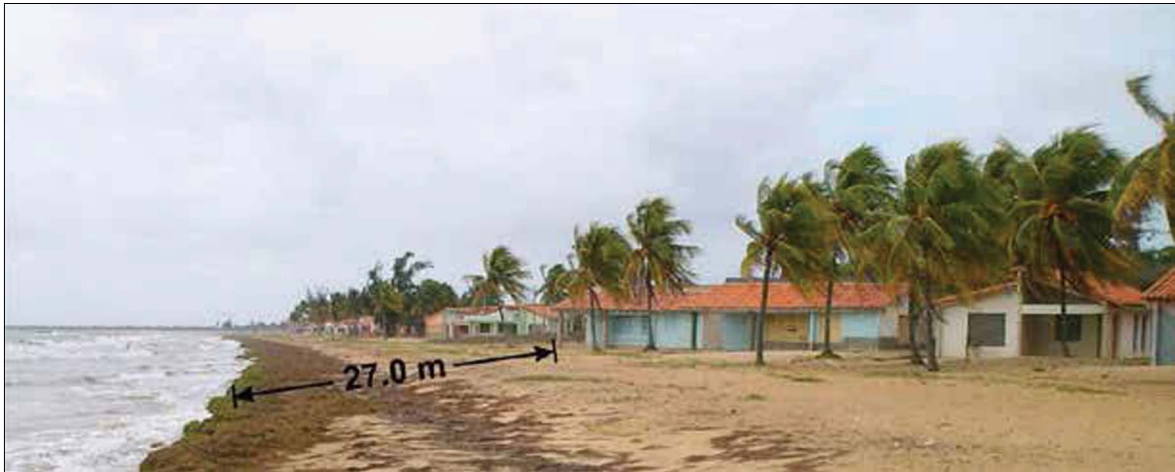
Figura 9. Posición de las construcciones respecto a las dunas en el sector norte de la playa Bailén. La cercanía de las construcciones acelera los procesos erosivos, especialmente frente a eventos meteorológicos extremos.
