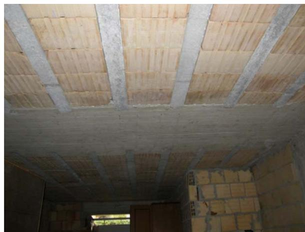
Figura 15. Edificio de mampostería confinada y forjados con vigas planas.
