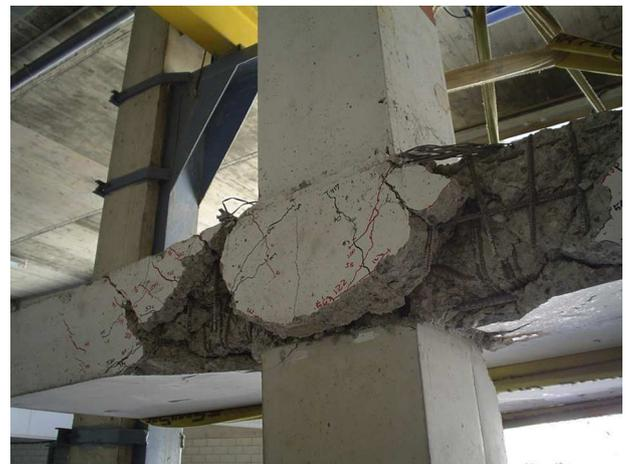
**Figura 14.** Estado de la unión colapsada.
