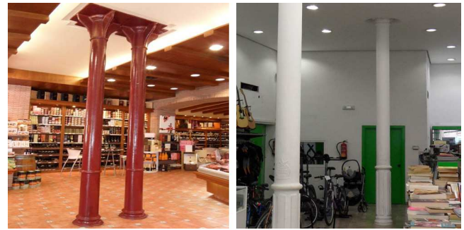
Figura 6. Pilares de fundición en planta baja.
