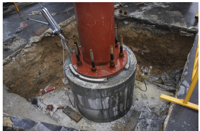
Figura 16. Cimentación de la cubierta baja norte.
