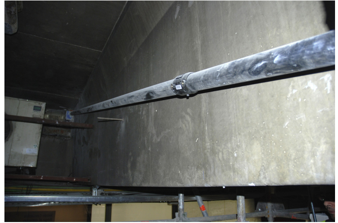
Figura 24. Refuerzo viga existente mediante postesado exterior.
