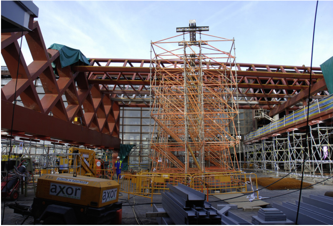
Figura 57. Montaje de la cubierta por módulos.
