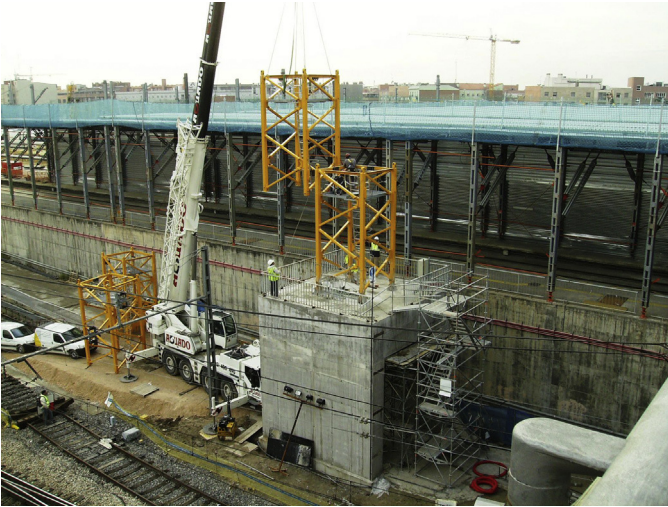
Figura 50. Pórtico para grúa torre entre cercanías y alta velocidad.
