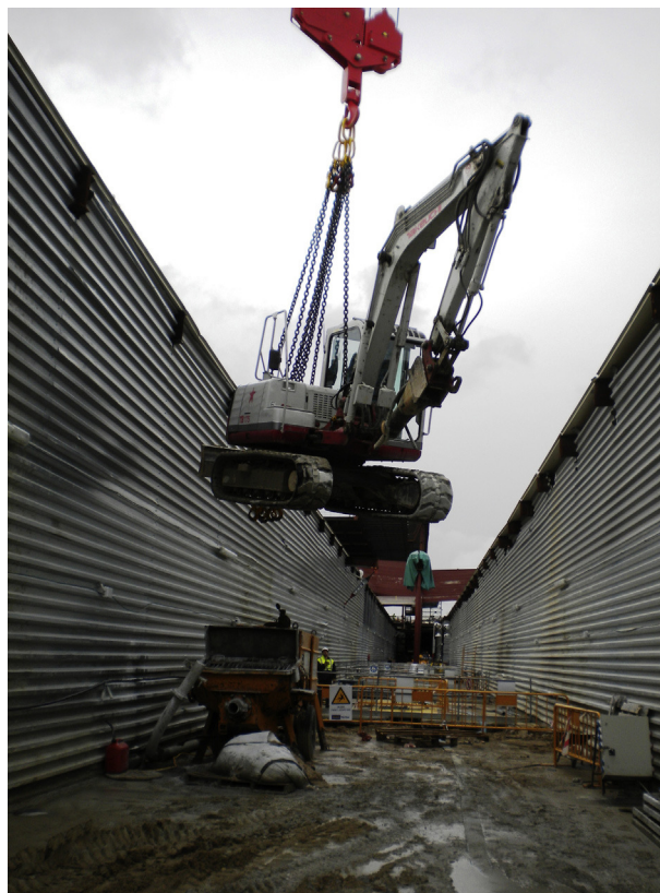
Figura 45. Acceso de maquinaria a los andenes.
