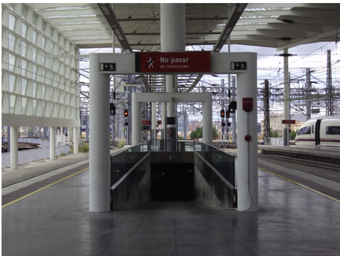
Figura 10. Rampas de catering, aspecto terminado.
