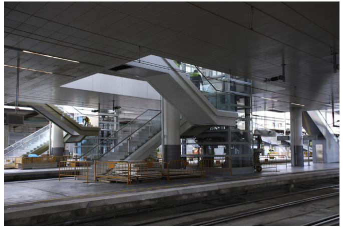
Figura 6. Escalera de acceso.
