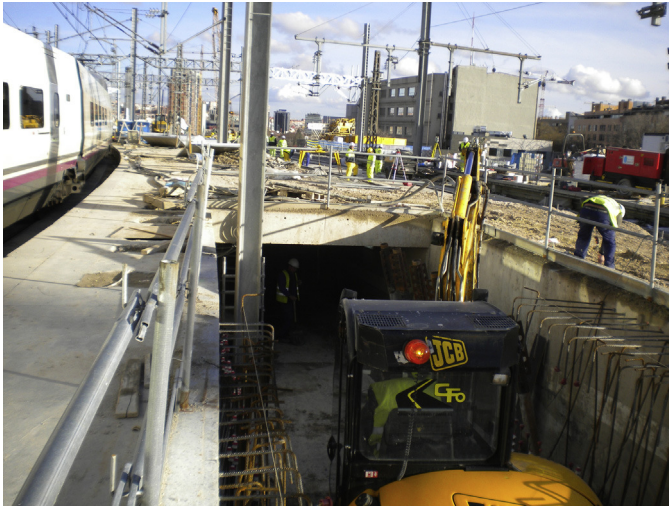
Figura 9. Rampas de catering durante la ejecución.
