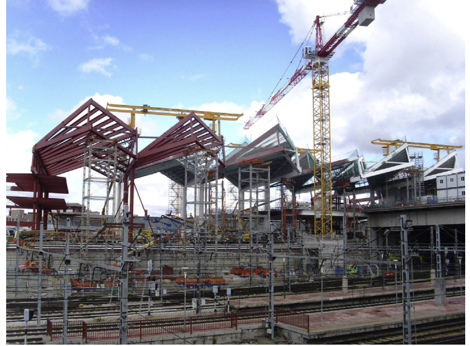
Figura 53. Torres de apeo sobre cercanías.
