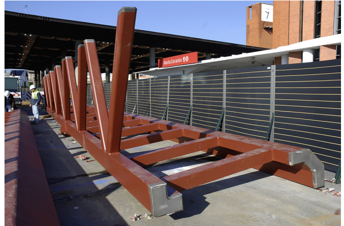
Figura 58. Módulo de cubierta a pie de obra.
