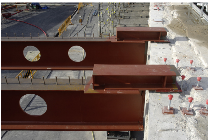
Figura 32. Apoyo a media madera deslizante (vista durante la construcción).
