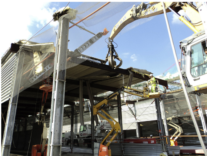
Figura 44. Demolición de los túneles provisionales.
