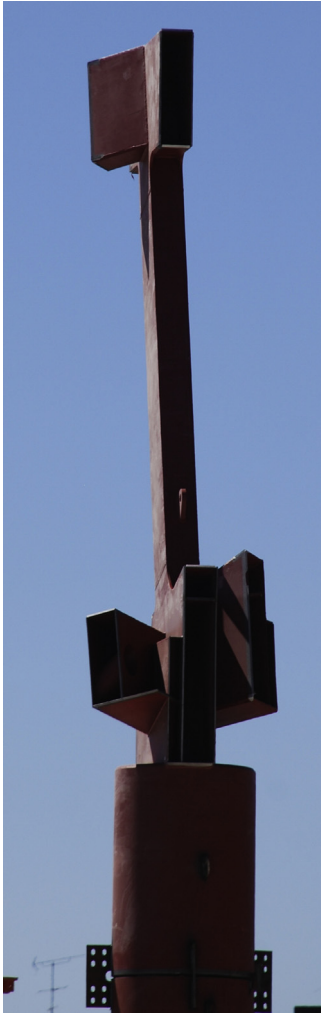
Figura 18. Nudo de cubierta alta durante el montaje.
