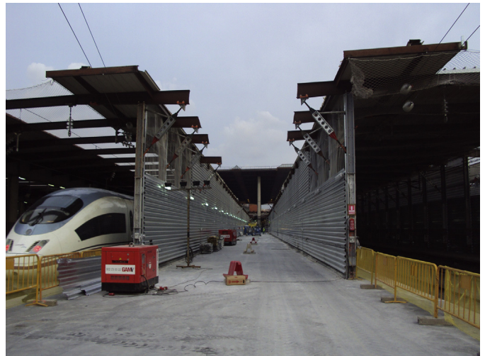
Figura 36. Túneles provisionales para la protección de vías.
