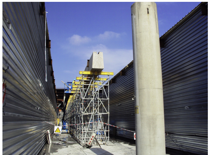
Figura 42. Demolición de las marquesinas existentes entre túneles provisionales para la protección de vías.
