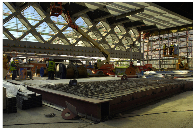
Figura 20. Ejecución del emparillado metálico, previamente al hormigonado del forjado mixto.
