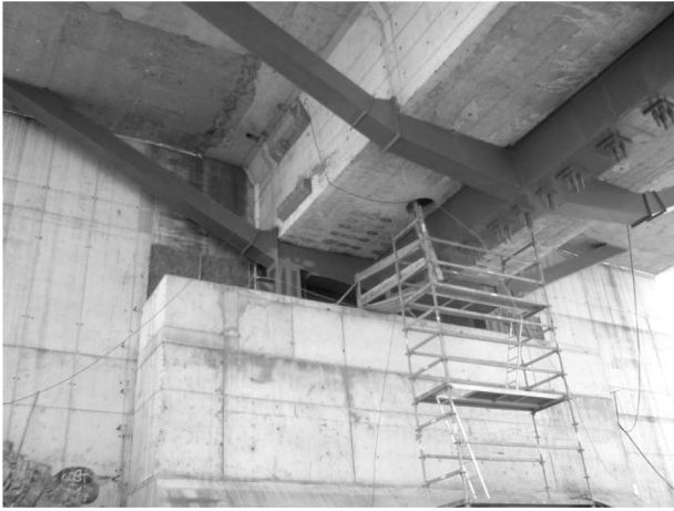
Figura 39. Fotografía de la ampliación del estribo del lado Asturias.
