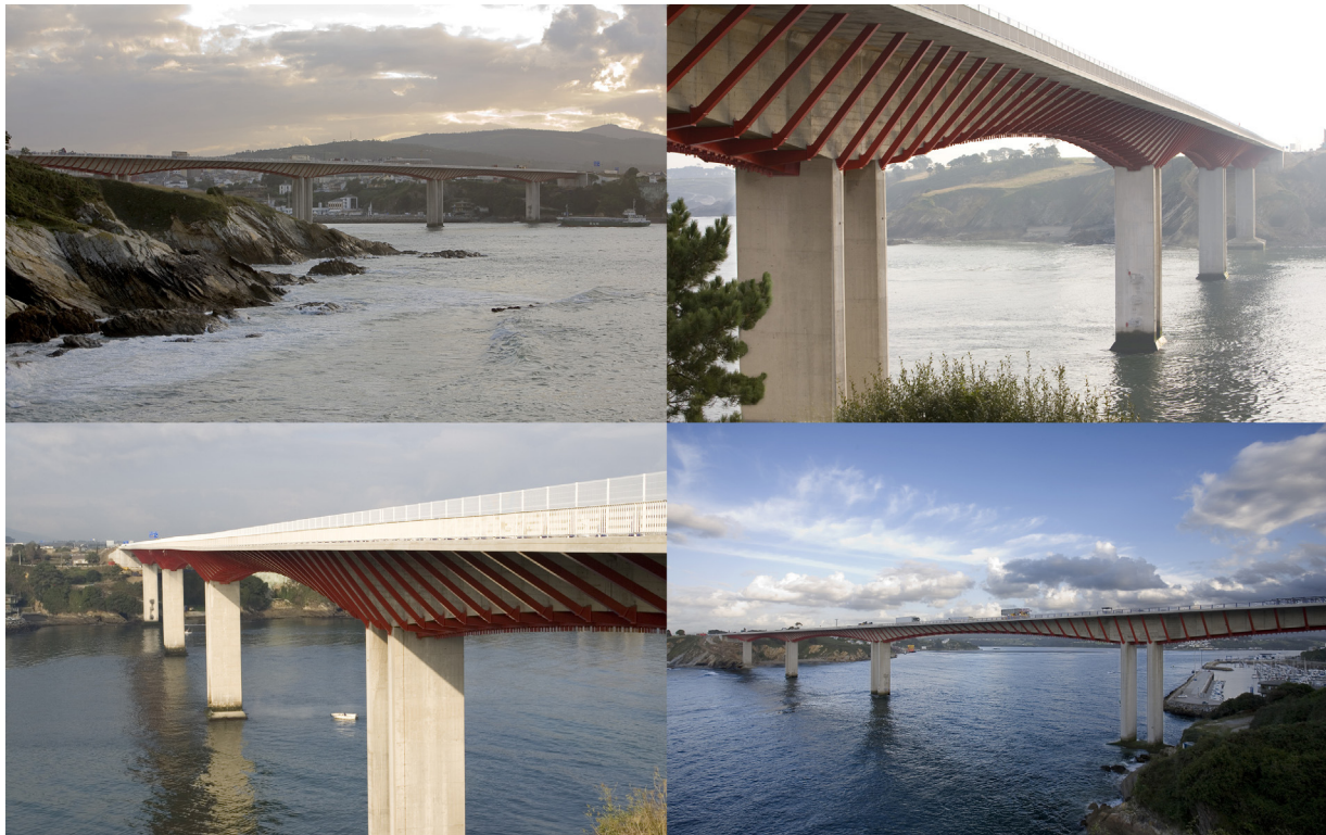
Figura 45. Vista del puente de Los Santos con las obras de ampliación terminadas.
