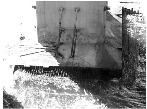
Figura 18. Construcción del zuncho perimetral de pila 4.
