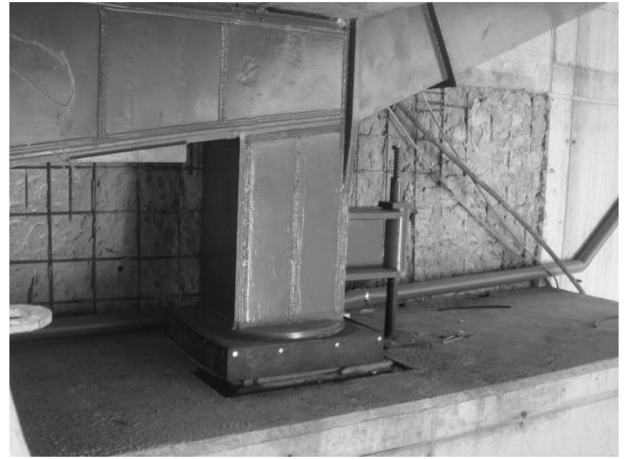
Figura 44. Fotografía de una de las nuevas patas de apoyo dispuestas en los estribos. Se puede ver una de las barras del sistema antivuelco del tablero y el faldón de protección dispuesto en el POT.
