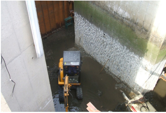
Figura 12. Vista del espacio entre fustes de la pila. Se distingue la superficie rugosa.
