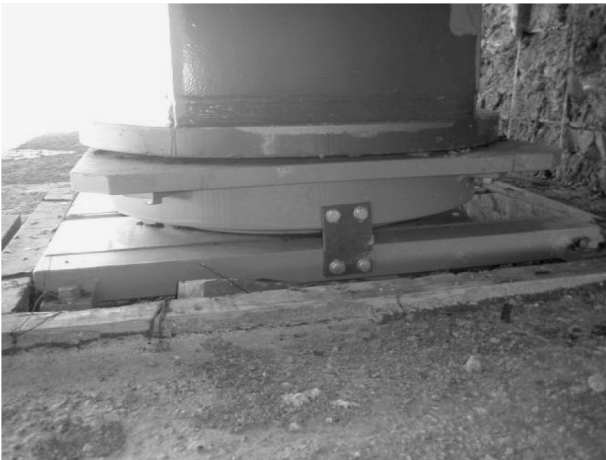
Figura 42. Aparatos de apoyo tipo POT. Puede observarse que, contrariamente a lo habitual, la placa de deslizamiento se dispuso debajo del apoyo para facilitar el centrado del apoyo en la pata metálica.
