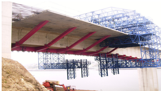
Figura 33. Cimbra móvil para la instalación de jabalcones y hormigonado de la losa ampliada.
