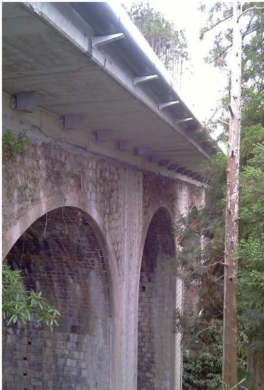
Figura 17. Vista parcial de la estructura terminada.
