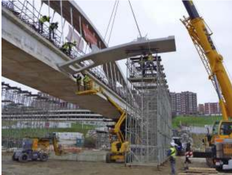
Figura 17. Vista de la colocación con grúa de un jабalcón prefabricado.
