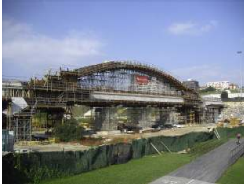
Figura 15. Vista de la cimbra cuajada del arco apoyada en el tablero.
