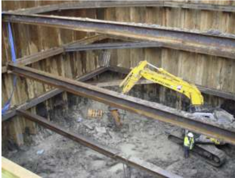
Figura 13. Vista del recinto de tablestacas de estribo 2 durante su ejecución.
