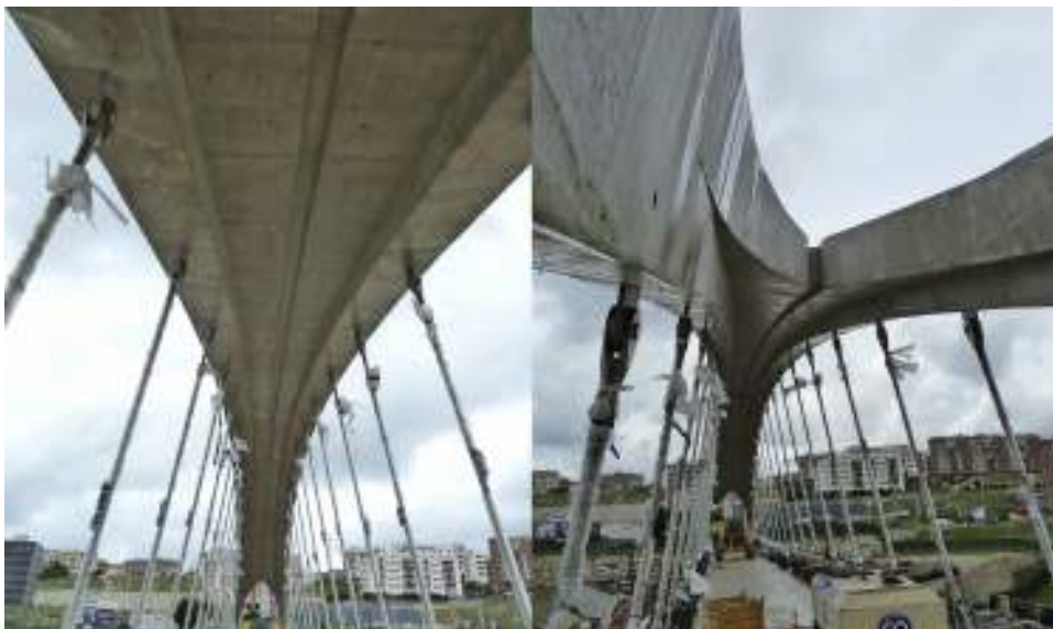
Figura 16. Vistas de las péndolas durante la puesta en carga.
