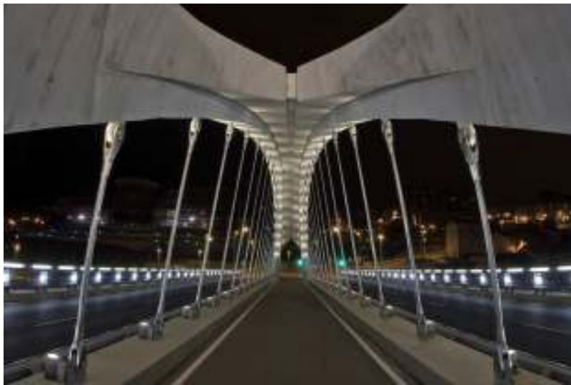
Figura 20. Vista interior nocturna del arco y el carril bici.
