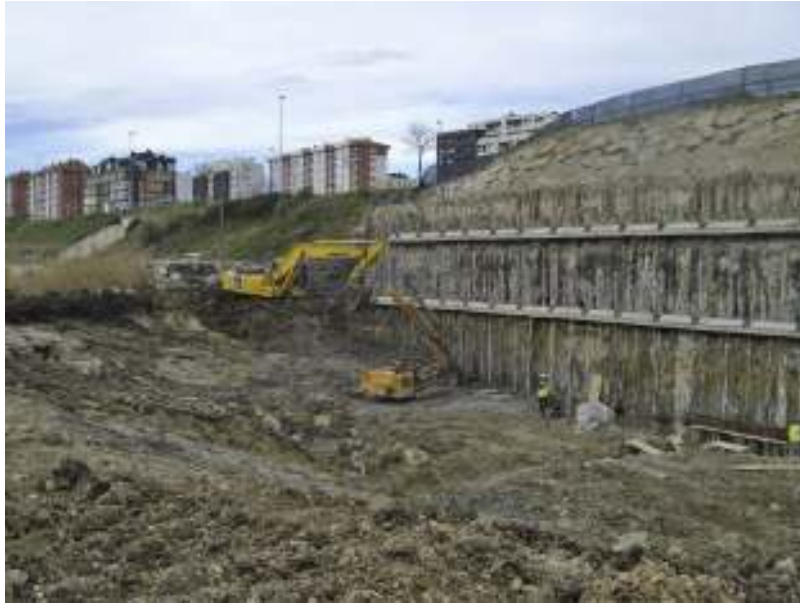
Figura 12. Vista del muro de micropilotes de estribo 1 durante su ejecución.
