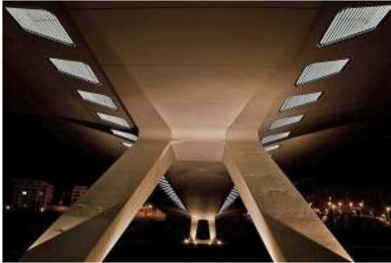
Figura 22. Vista inferior nocturna del puente y la iluminación desde jabalcones.
