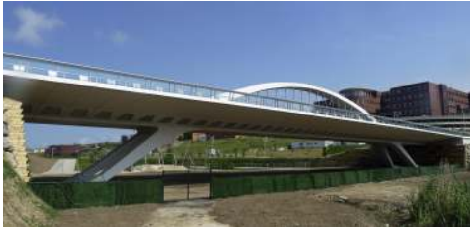
Figura 23. Vista diurna del puente acabado.
