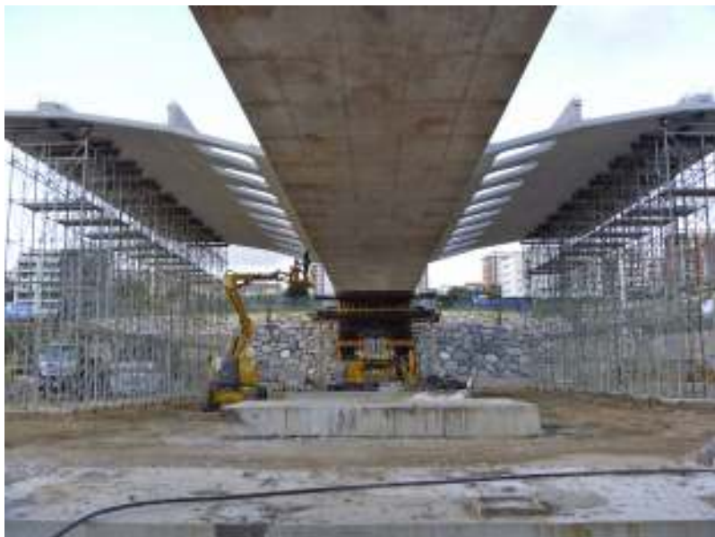
Figura 18. Vista de los jабalcones de voladizos sobre apeos provisionales al terreno.
