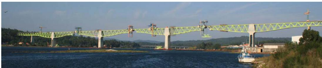
Figura 42. Izado de dovela de cierre del vano 6.
