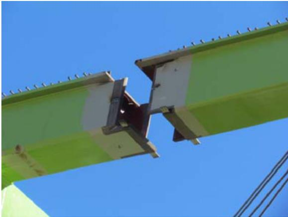
Figura 16. Detalle de empalme de nudo-cordón superior, con soldaduras deca-ladas.
