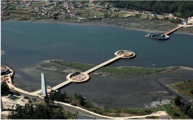
Figura 5. Vista del pantalán y los recintos de las cimentaciones de las pilas P-5, P-6 y P-7 en el cauce.
