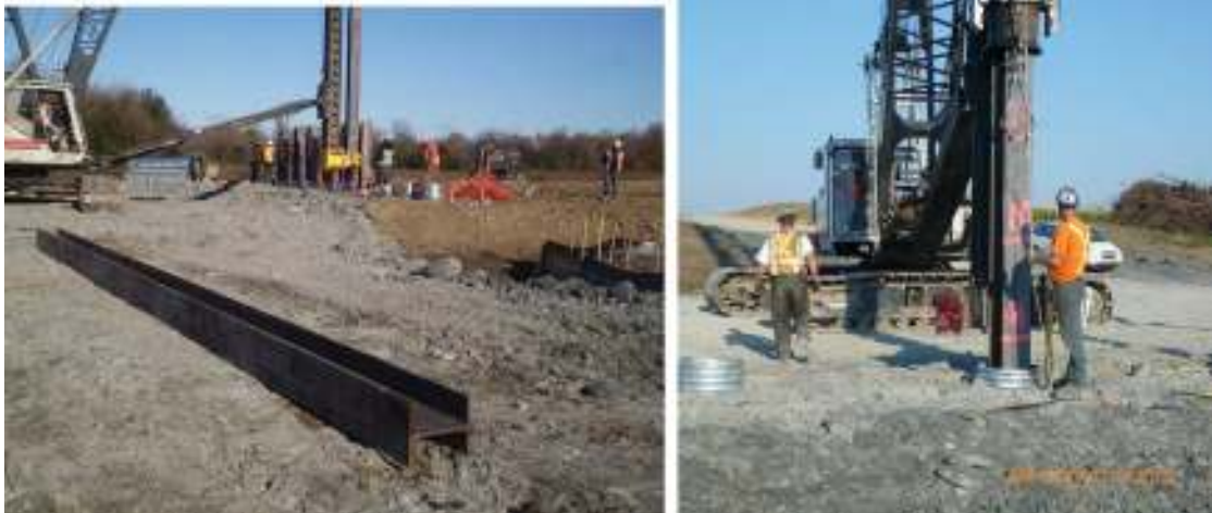
Figura 15. Hincia de pilotes metálicos.
