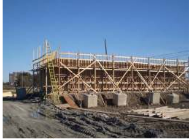
Figura 4. Encofrado de estribo este W12.
