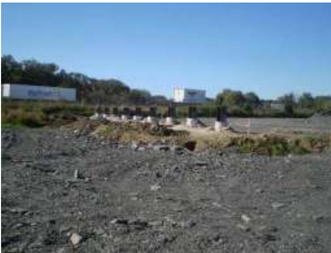
Figura 3. Cimentación de estribo W10.
