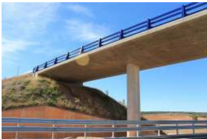
Figura 20. Pilas empotradas en Ossa de Montiel.
