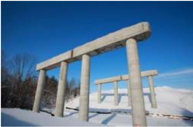
Figura 11. Pilas pórtico 407E.
