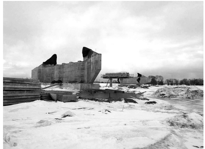
Figura 17. Estribo semintegral.
