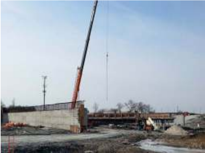
Figura 2. Construcción de estribo W6.
