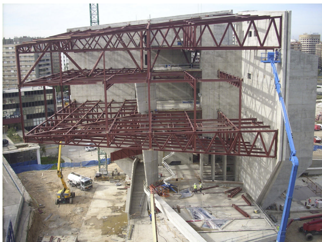
Figura 13. Vista de la viga diagonal VD.
