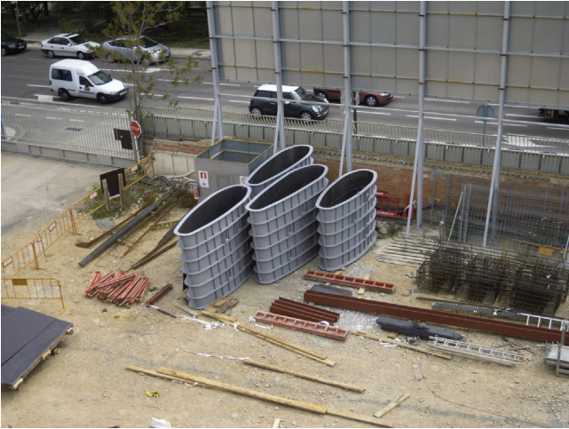
Figura 11. Encofrado metálico del pilar fusiforme.
