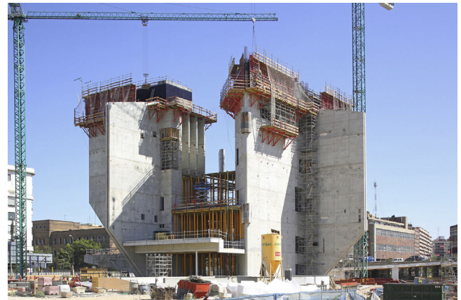
Figura 16. Encofrado trepante.
