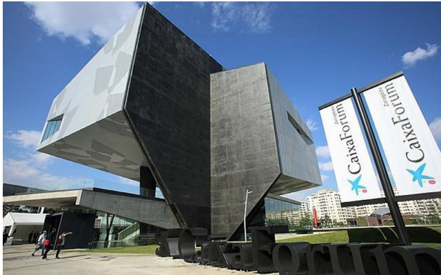
Figura 7. Vista del muro en L.
