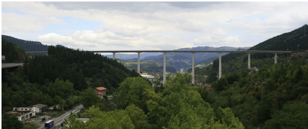
Figura 11. Imagen del viaducto construido de hormigón pretensado.
