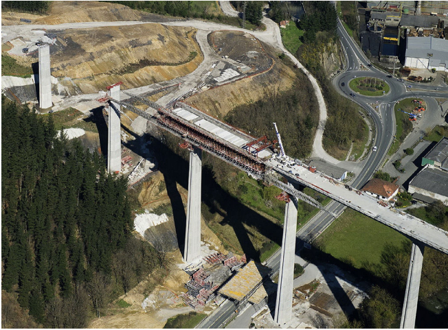
Figura 23. Colocación de prelasas sobre la sección artesa previamente hormigonada.
