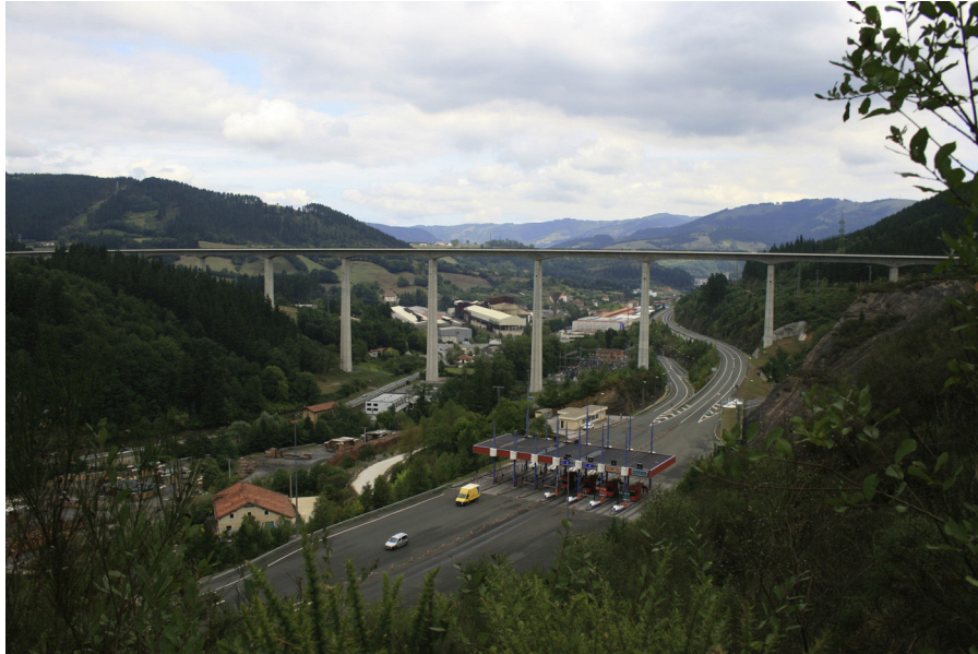
Figura 45. Imagen del viaducto concluido.
