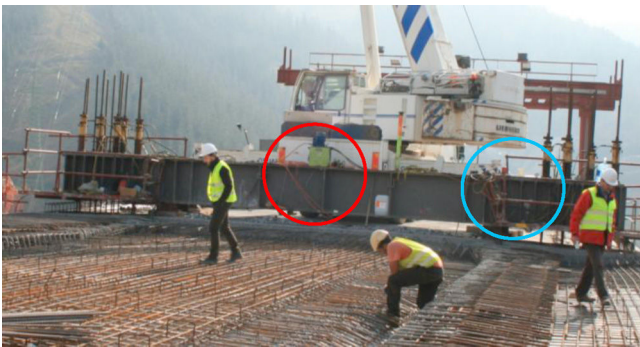
Figura 33. Vista de la viga transversal de cuelgue; en rojo: extensómetros en las alas en el centro de vano; en azul: extensómetro de alma junto al apoyo lateral.
