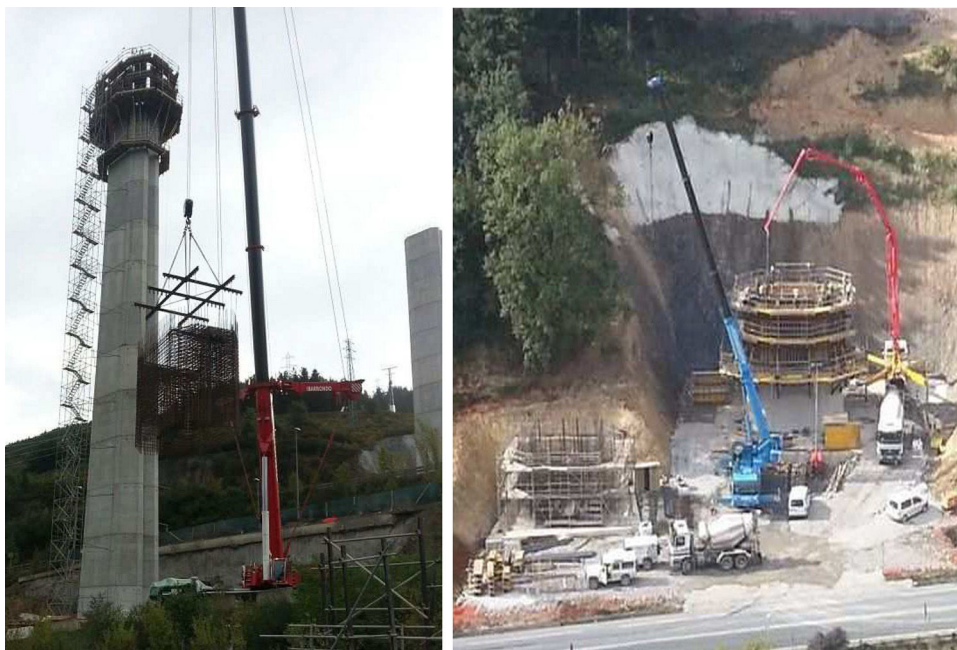
Figura 19. Premontaje e izado de ferralla de una trepa y hormigonado con bomba.
