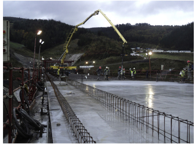
Figura 24. Vista del hormigonado de la losa superior con bomba desde el frontal de la fase previa.
