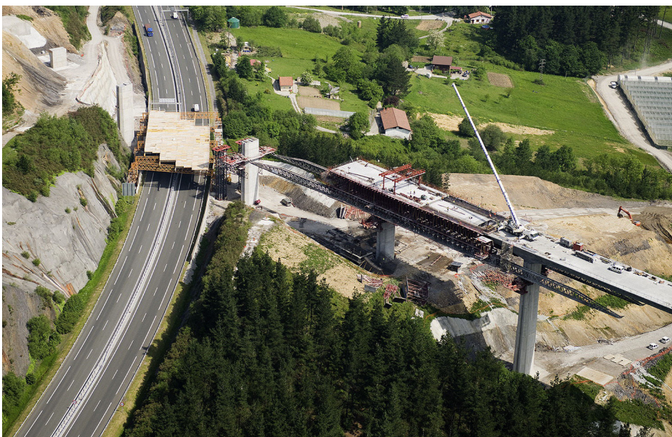
Figura 25. Vista de la zona de negativos completamente hormigonada y colocación de prelasas en el tramo de positivos sobre el que se ferrallará y hormigonará la losa posteriormente.
