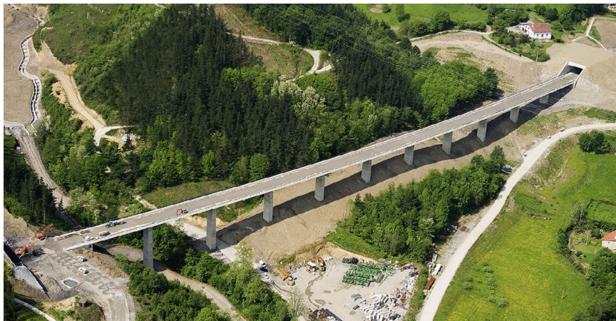
Figura 2. Imagen del viaducto de Lamiategui.
