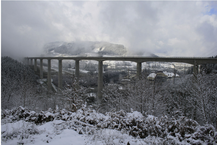
Figura 43. Imagen del viaducto durante la prueba de carga con camiones (4 de febrero de 2015).
