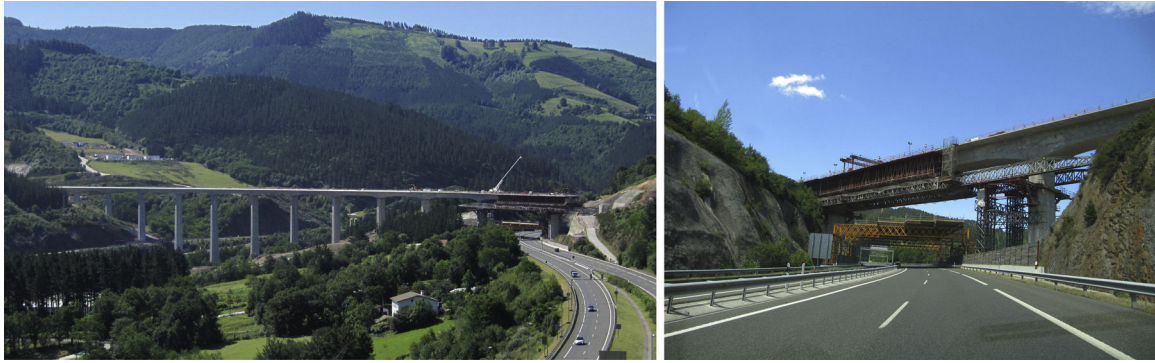
Figura 30. Imágenes de la autocimbra sobre la AP-1 con el vano de 80 m, actual récord de luz de España en alta velocidad ejecutado con autocimbra.
