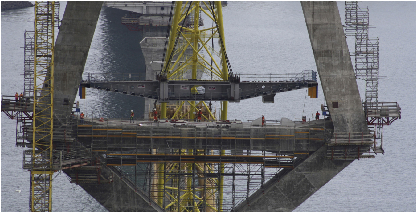
Figura 3. Colocación de la dovela OP12.
