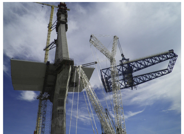
Figura 5. Colocación de los carros de izado sobre el tablero.
