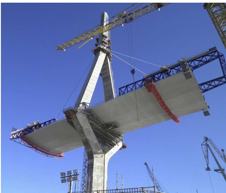
Figura 7. Tablero sustentado por los tirantes provisionales y la primera pareja de definitivos.
