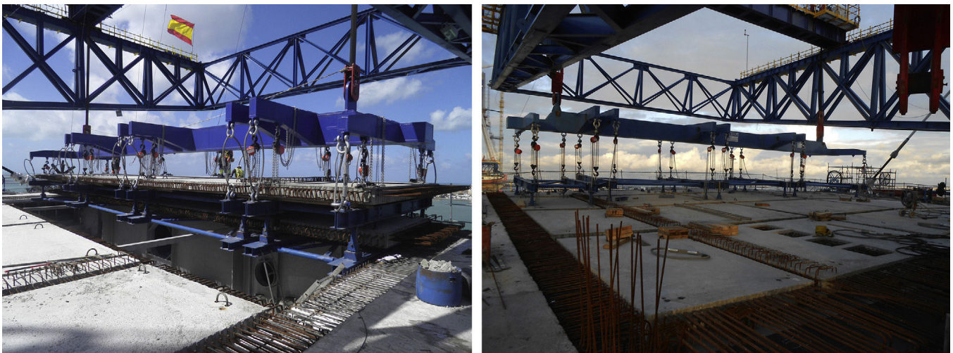
Figura 11. Colocación de las losas sobre el tablero.
