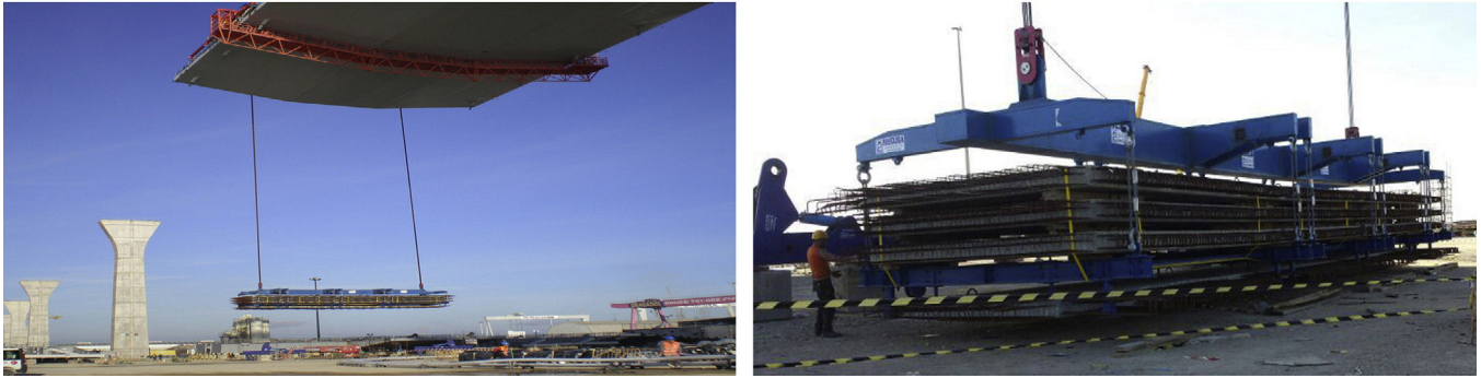
Figura 10. Izado del paquete de losas prefabricadas.
