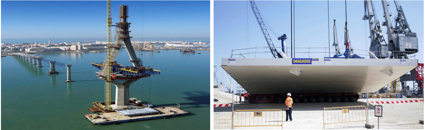
Figura 6. Dovelas situadas bajo la sombra del tablero.
