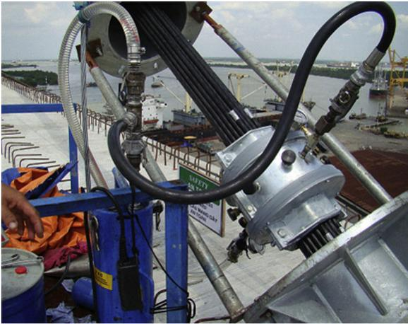
Figura 8. Montaje de los amortiguadores.
