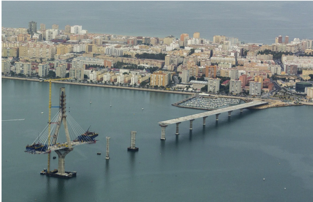
Figura 1. Vista general del tramo empujado.
