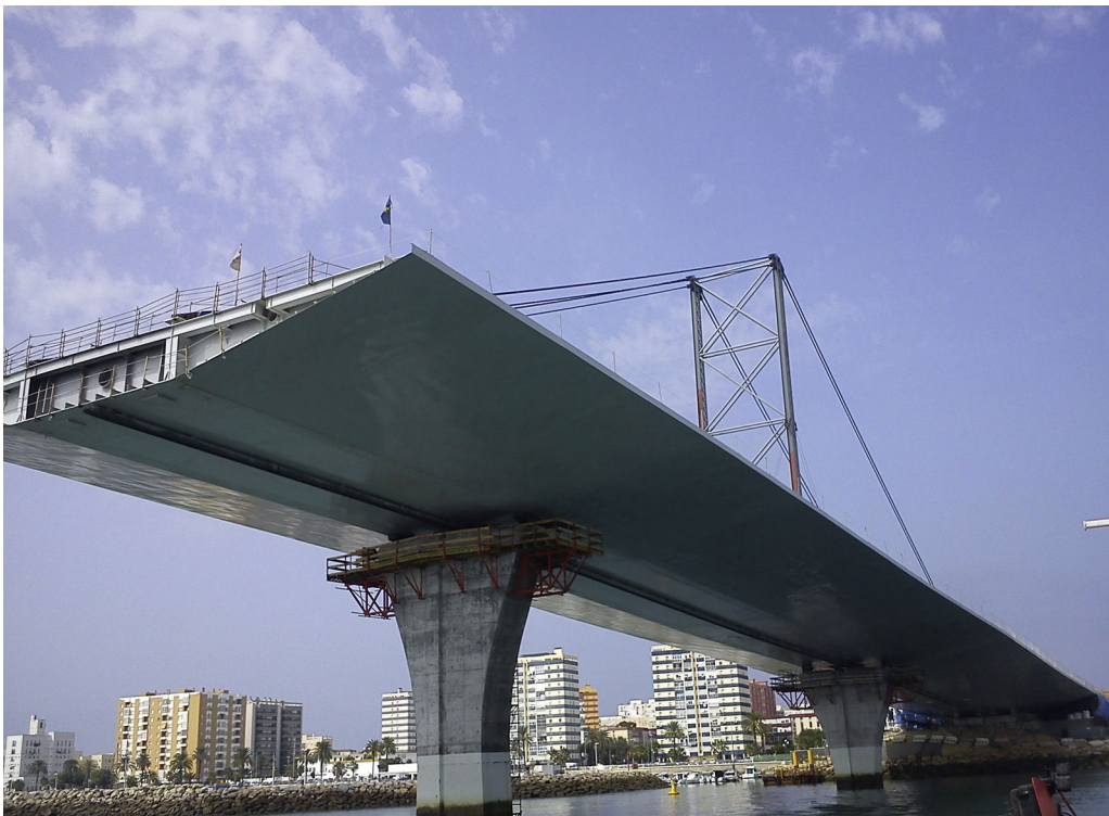
Figura 11. Vista inferior del tablero.
