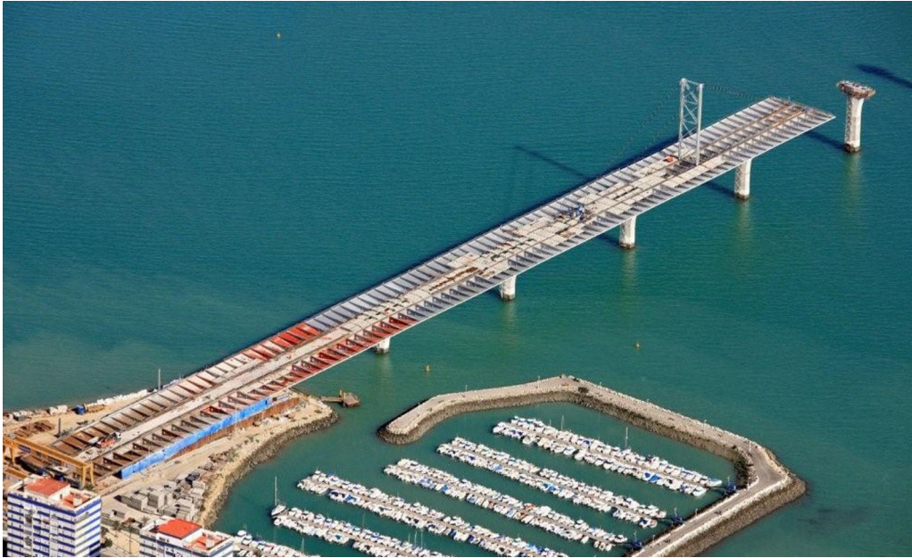
Figura 10. Vista aérea del tablero durante el empuje.
