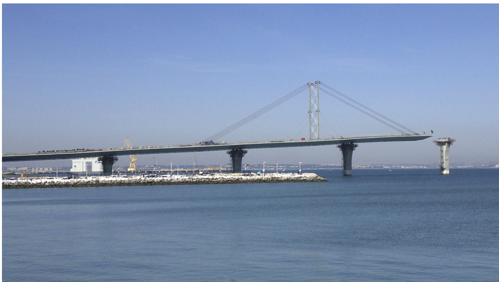
Figura 9. Sistema de atirantamiento provisional.
