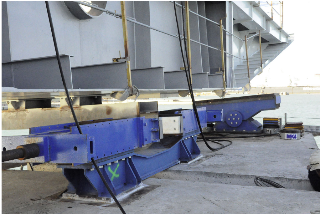
Figura 4. Detalle de guiadera longitudinal.
