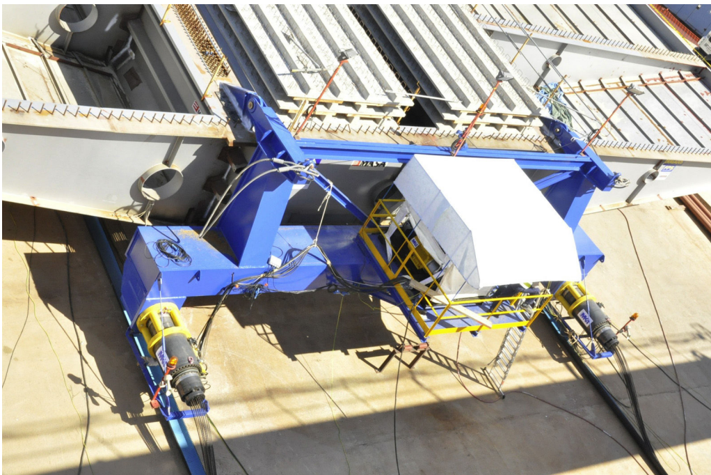
Figura 7. Percha de tiro (azul) y gatos hidráulicos (gris).
