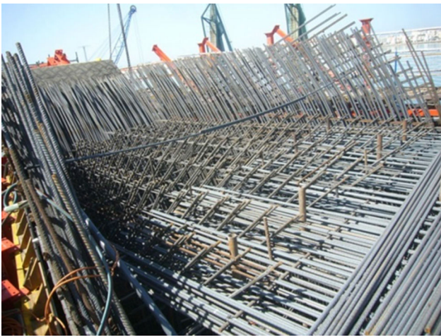
Figura 10. Fustes inclinados inferiores cimbrados.
