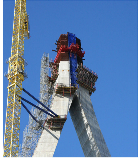
Figura 19. Montaje de cajones con grúa sobre cadenas.
