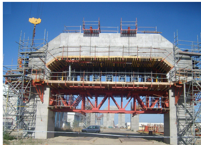
Figura 8. Construcción de pilas pórtico en tierra.
