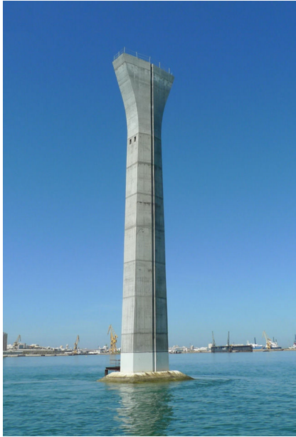
Figura 1. Pilas monofuste.
