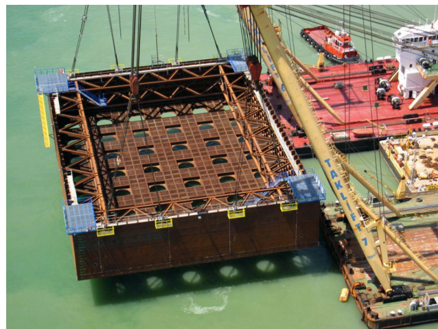
Figura 5. Recinto estanco de cimentación de torre de la bahía.
