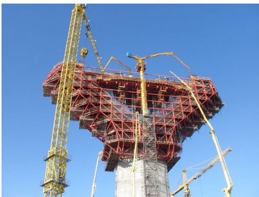
Figura 12. Cimbra de riostra.
