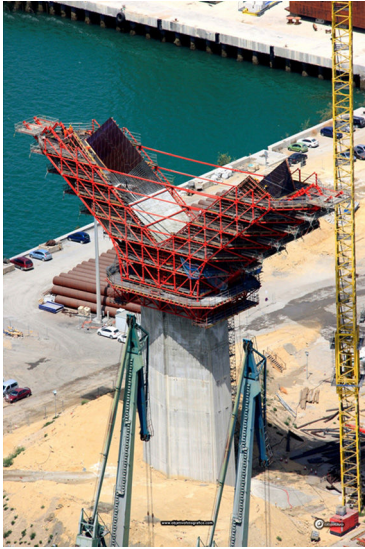
Figura 10. Fustes inclinados inferiores cimbrados.
