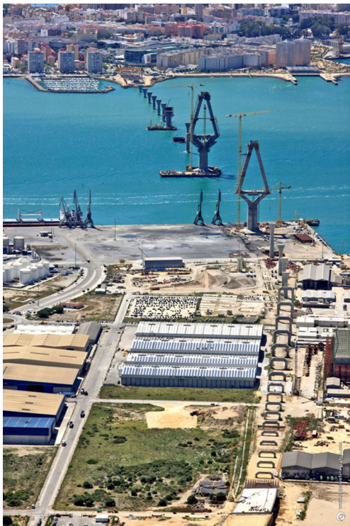
Figura 3. Vista general de pilas.
