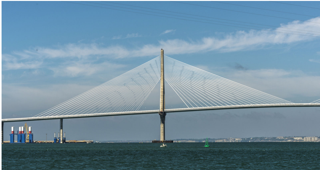
Figura 31. Vista lateral de la torre.
