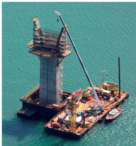
Figura 7. Construcción de pilas monofuste en mar.
