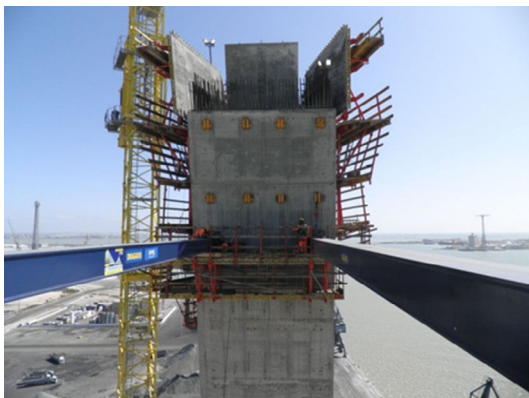
Figura 17. Puntales entre fustes inclinados superiores.
