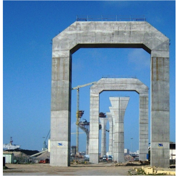
Figura 2. Pilas pórtico.
