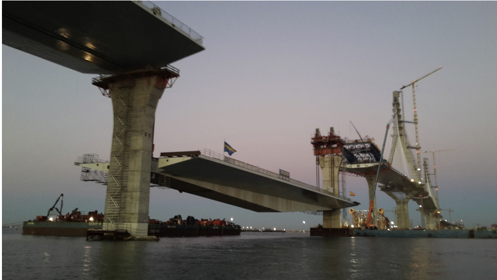
Figura 18. Izado del tramo desmontable.
