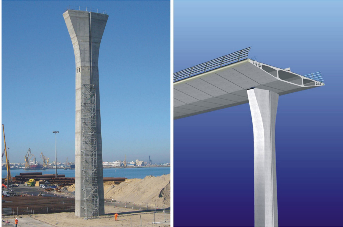
Figura 29. Vista del viaducto de acceso al lado de Puerto Real, canto 3,00 m.
