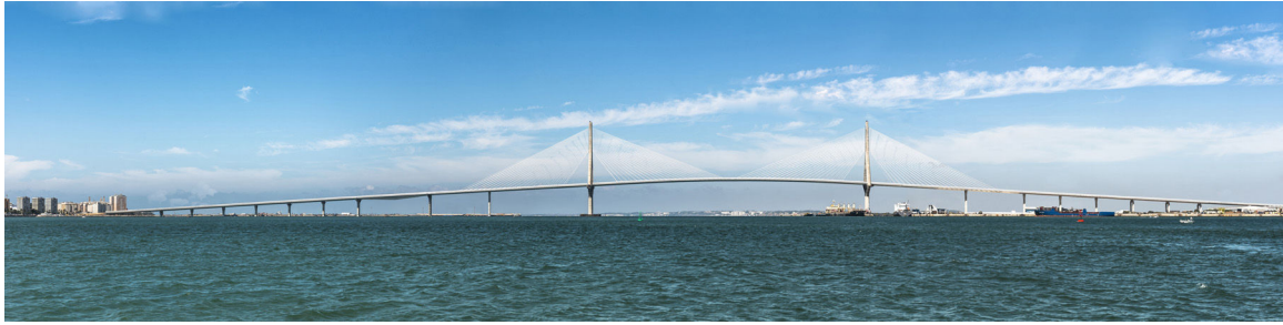
Figura 6. Vista general del puente.
