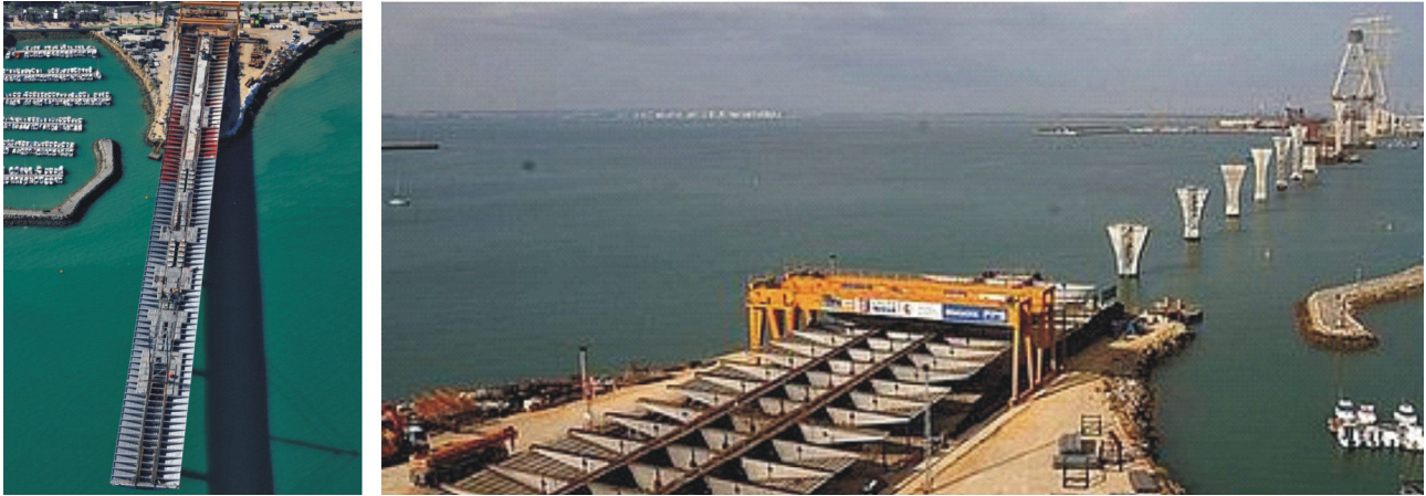
Figura 14. Otras vistas del proceso de empuje del tablero del viaducto al lado del acceso a Cádiz.
