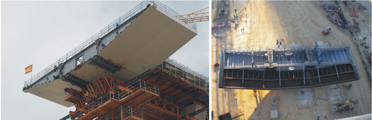
Figura 34. Dovela de conexión dintel mixto–dintel hormigón.
