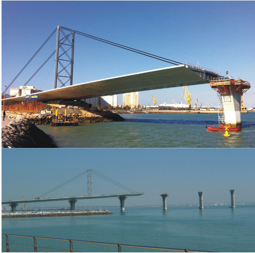
Figura 12. Empuje del tablero con la torre de atirantamiento provisional.
