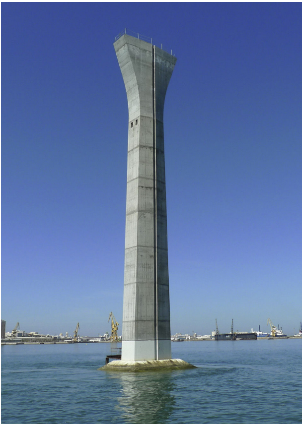
Figura 15. Fuste de las pilas.
