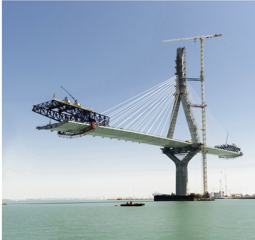
Figura 26. Construcción por avance en voladizo simétrico.
