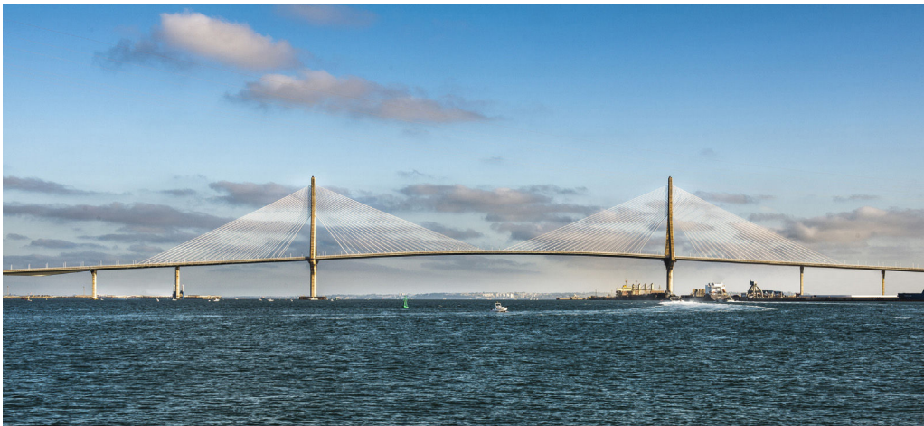
Figura 3. Vista parcial del puente.
