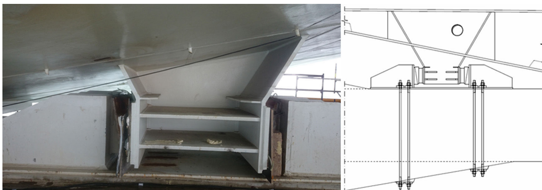
Figura 24. Topes transversales entre tablero y torres.
