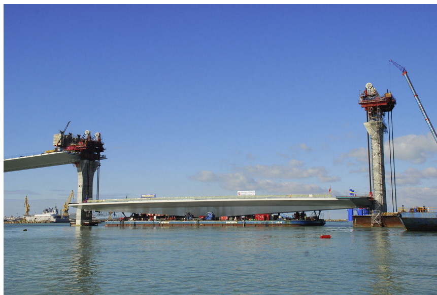
Figura 14. Posición de izado del vano desmontable entre pilas.
