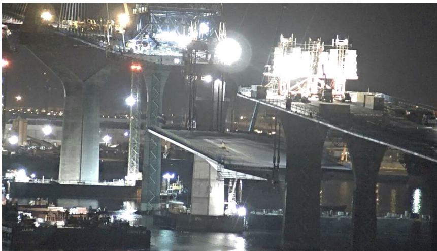
Figura 16. Giro del 5% del vano desmontable.
