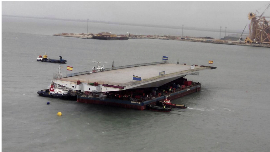
Figura 12. Transporte por mar del tramo desmontable.
