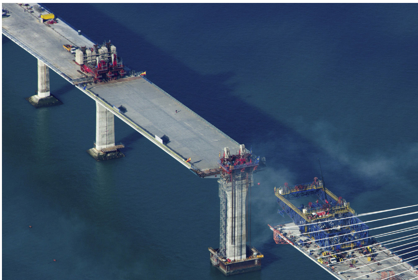
Figura 17. Vano desmontable apoyado en posición definitiva.
