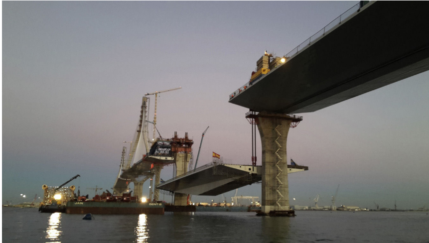
Figura 15. Izado del vano desmontable.
