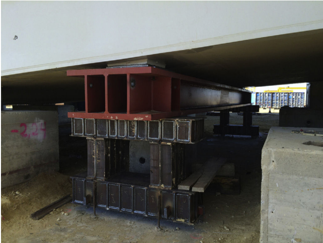
Figura 8. Apeos para pesaje del tramo desmontable.
