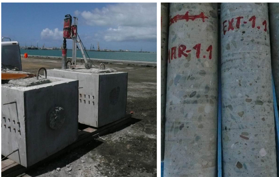
Figura 10. Extracción de testigos de los elementos de prueba.
