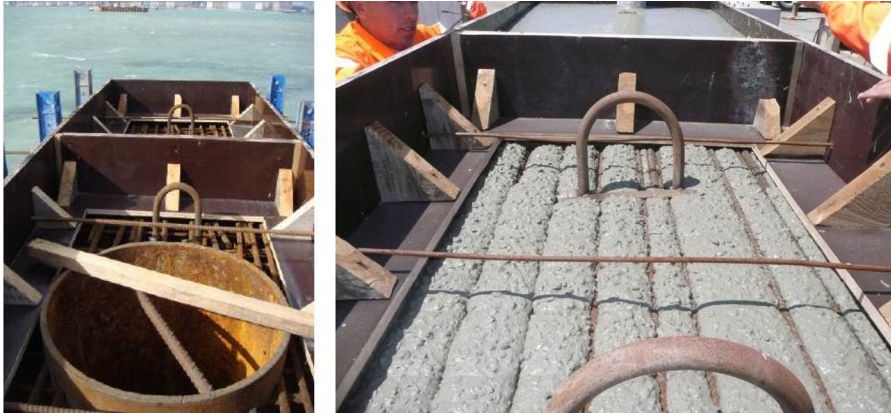
Figura 8. Llenado de molde en superficie.
