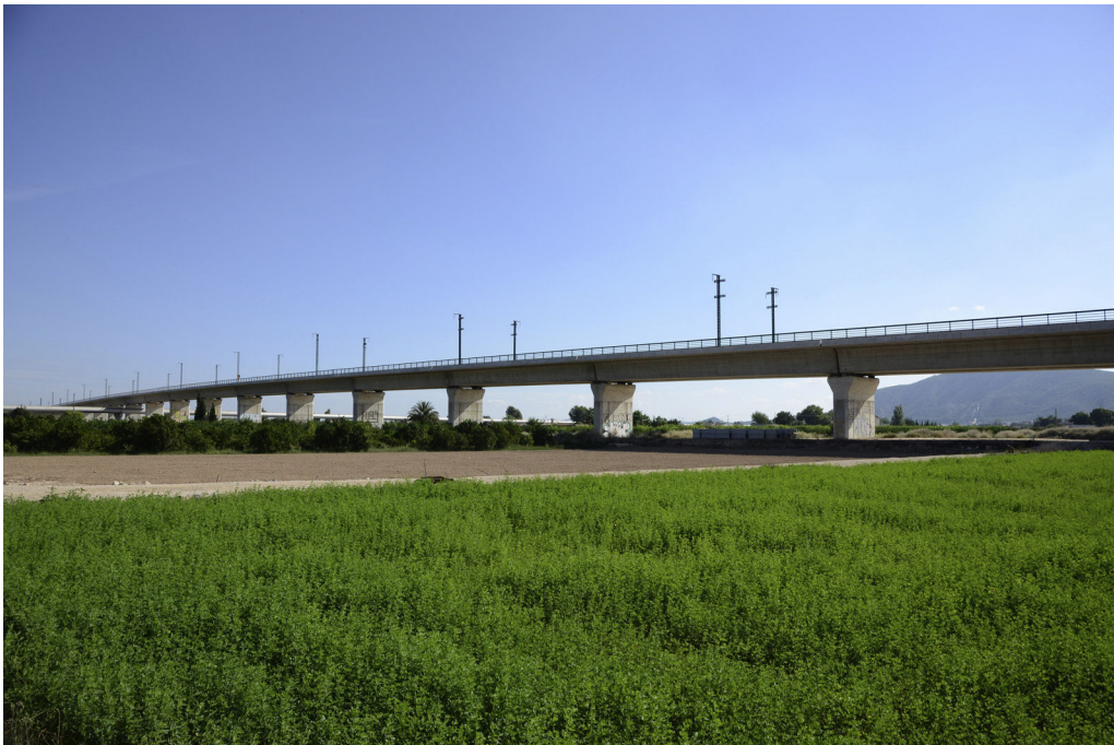
Figura 13. Fotografía Viaducto sobre Traspase Tajo-Segura.
