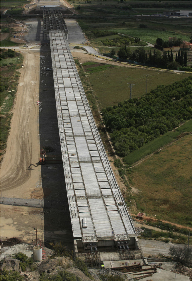
Figura 9. Fotografía Viaducto Callosa-Cox en construcción.
