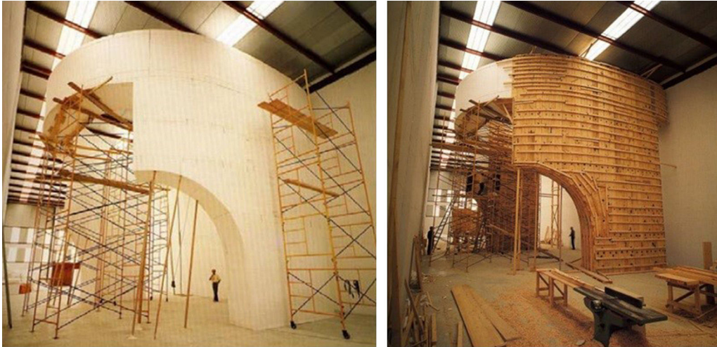
Figura 6. Maqueta de poliexpán realizada para la obra.
