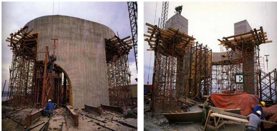
Figura 8. Imagen de la estructura metálica que soportó el encofrado.
