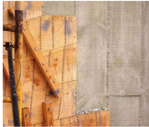
Figura 7. Marcado del encofrado.
