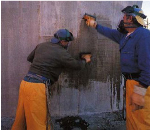
Figura 9. Limpieza final del hormigón.
