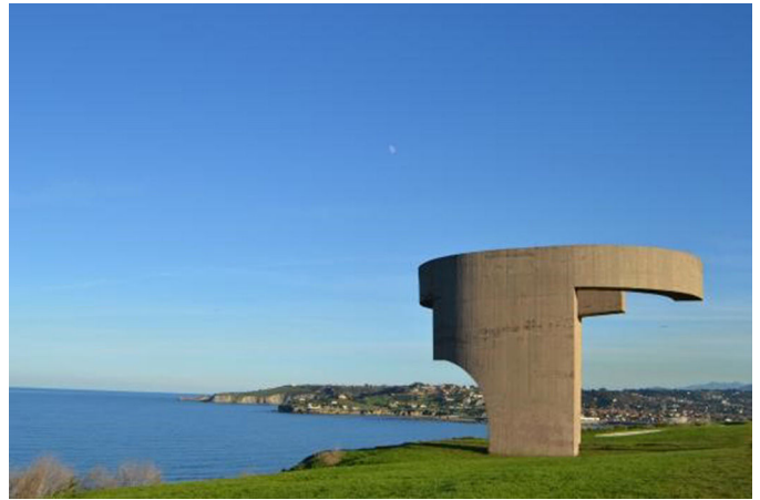
Figura 11. Estado final de la obra.
