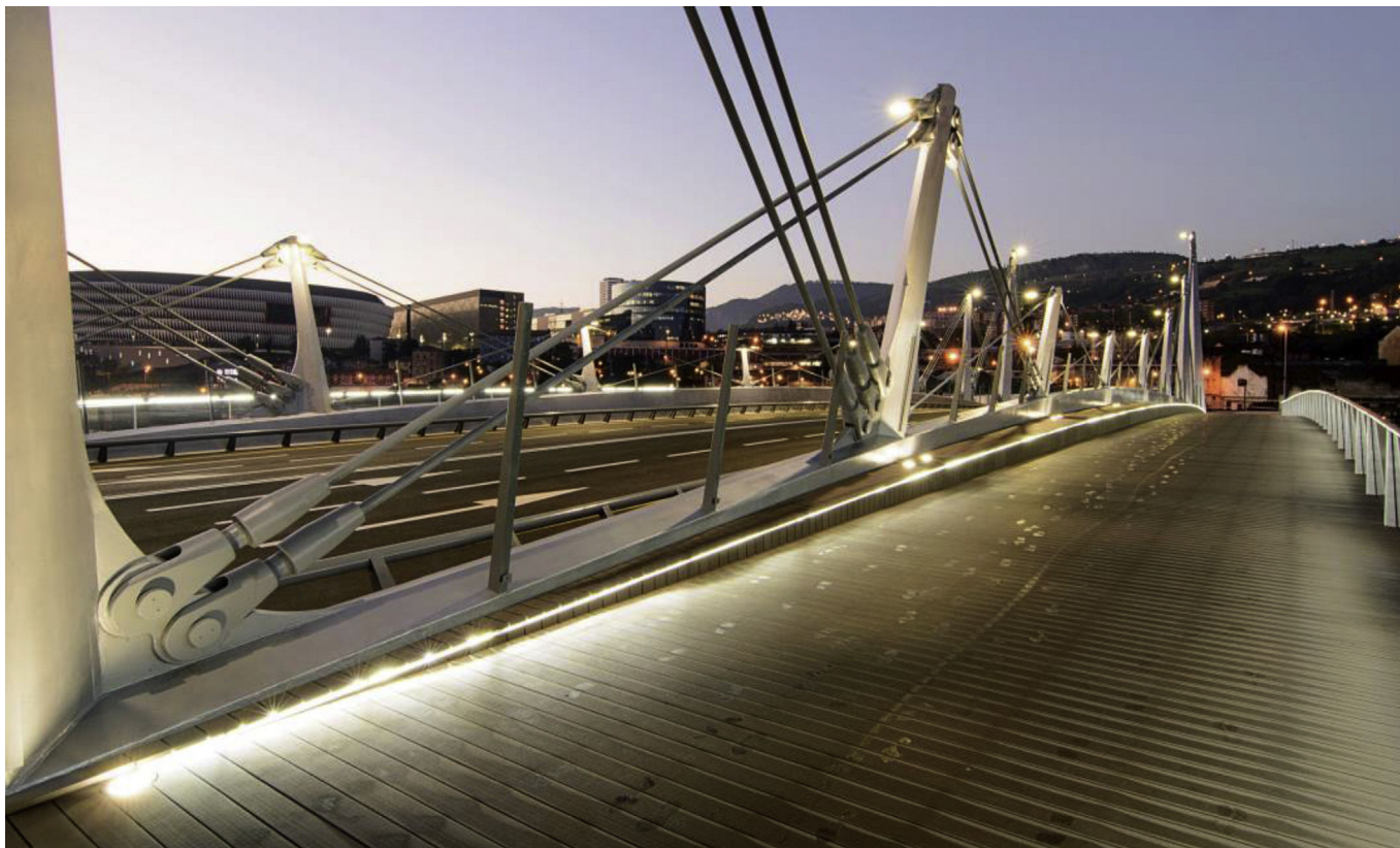
Figura 61. Vista del puente terminado (Foto: Carlos Garmendia).
