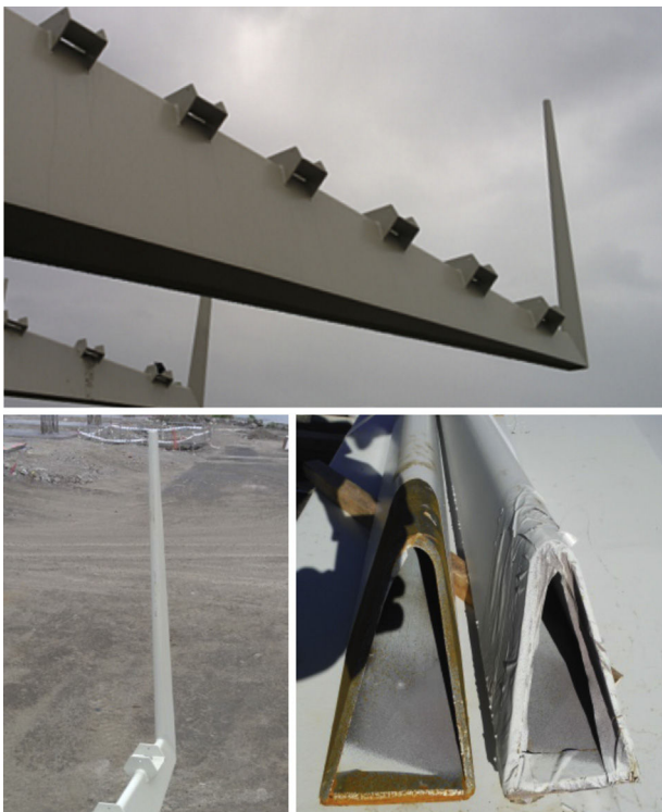
Figuras 37-39. Vistas de una costilla con montante vertical y detalle de chapa plegada.
