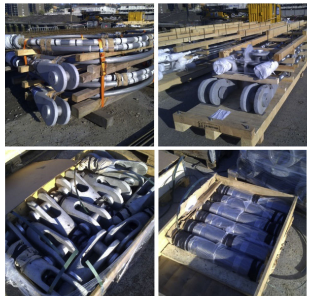
Figuras 40-43. Tirantes de cable cerrado acopiados en obra y elementos de terminales activos de los tirantes.
