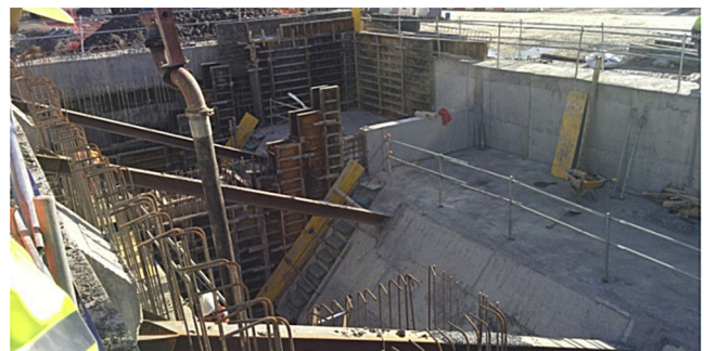
Figura 27. Vista interior del estribo 2.
