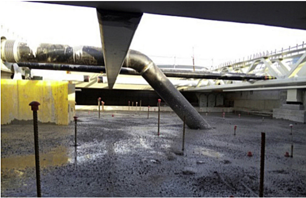
Figura 28. Hormigonado de contrapeso.
