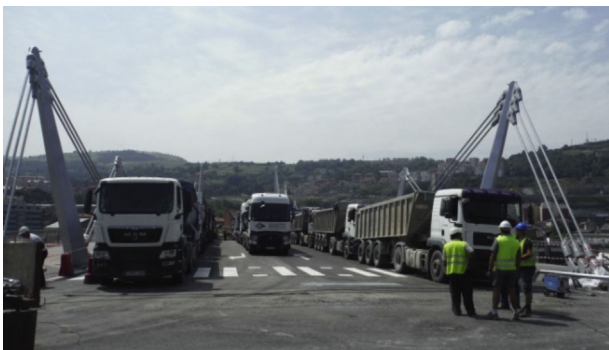
Figura 56. Prueba de carga estática.
