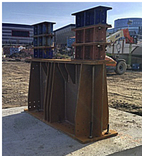
Figuras 29 y 30. Apoyo provisional, previamente a colocar la estructura y con el gato de apeo.
