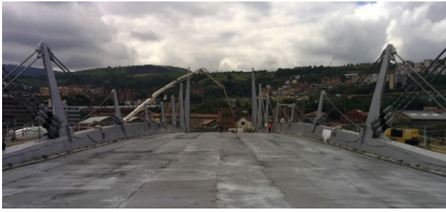
Figura 50. Hormigonado de la losa.
