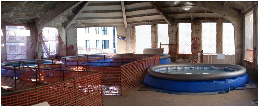
Figura 17. Vista de las bañeras de agua usadas para la prueba de carga de los forjados.
