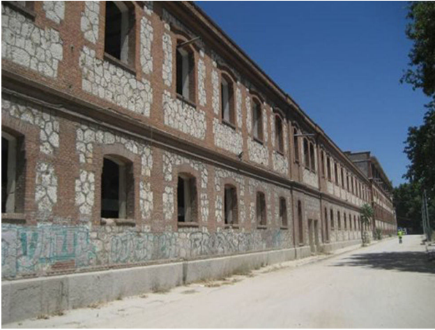
Figura 4. Vista exterior de la nave 9.
