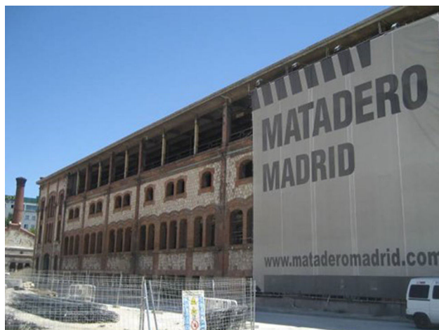
Figura 3. Vista exterior de la nave 8.
