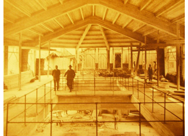
Figura 15. Vista del interior de la Serrería, fotografía del edificio en su estado original.
