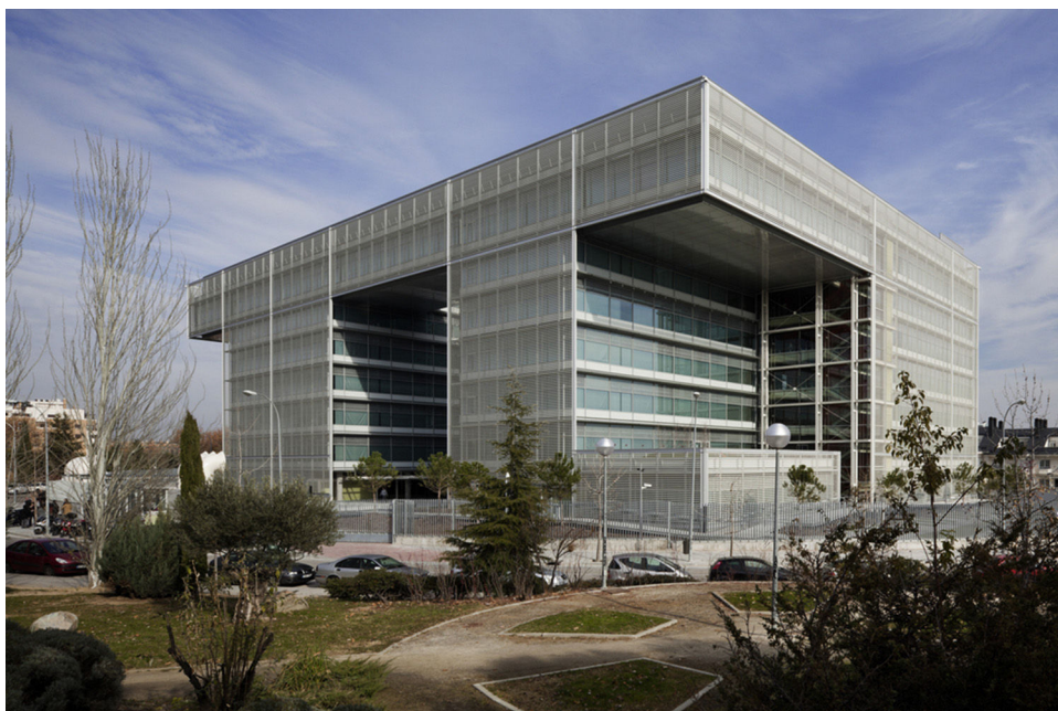
Figura 3. Edificio del nuevo Centro de Proceso de Datos en la calle Abelas (fase I) [1].
