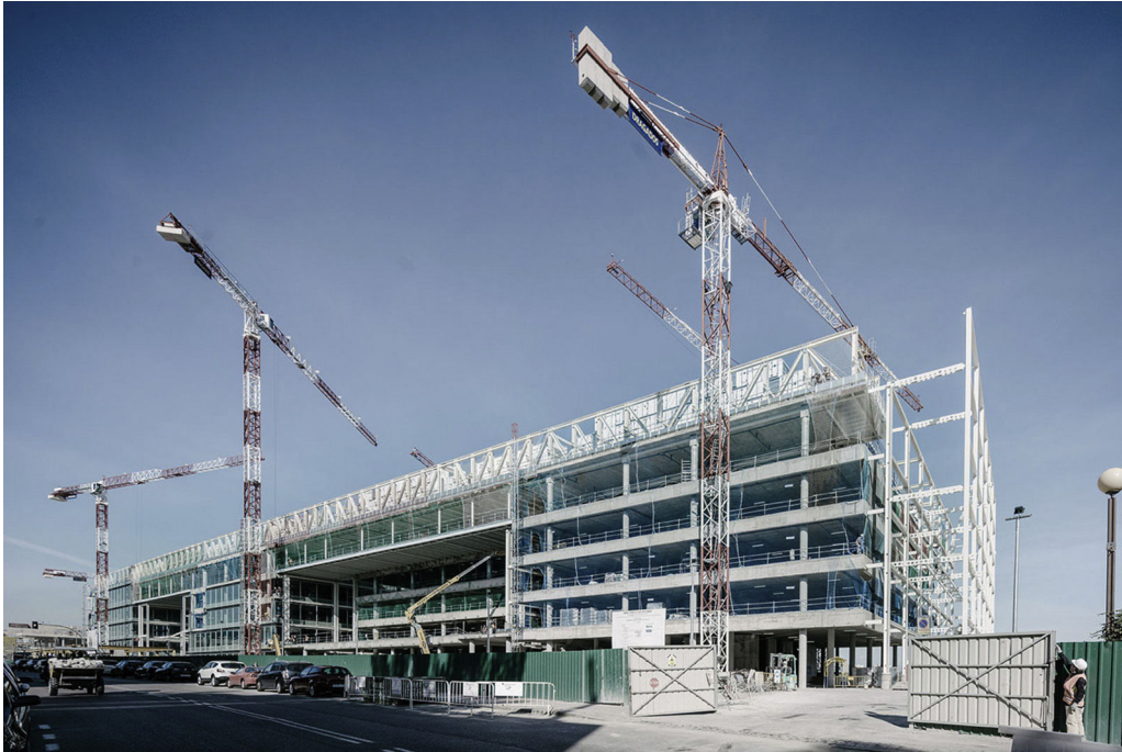
Figura 37. Imagen de las obras con la estructura terminada.
