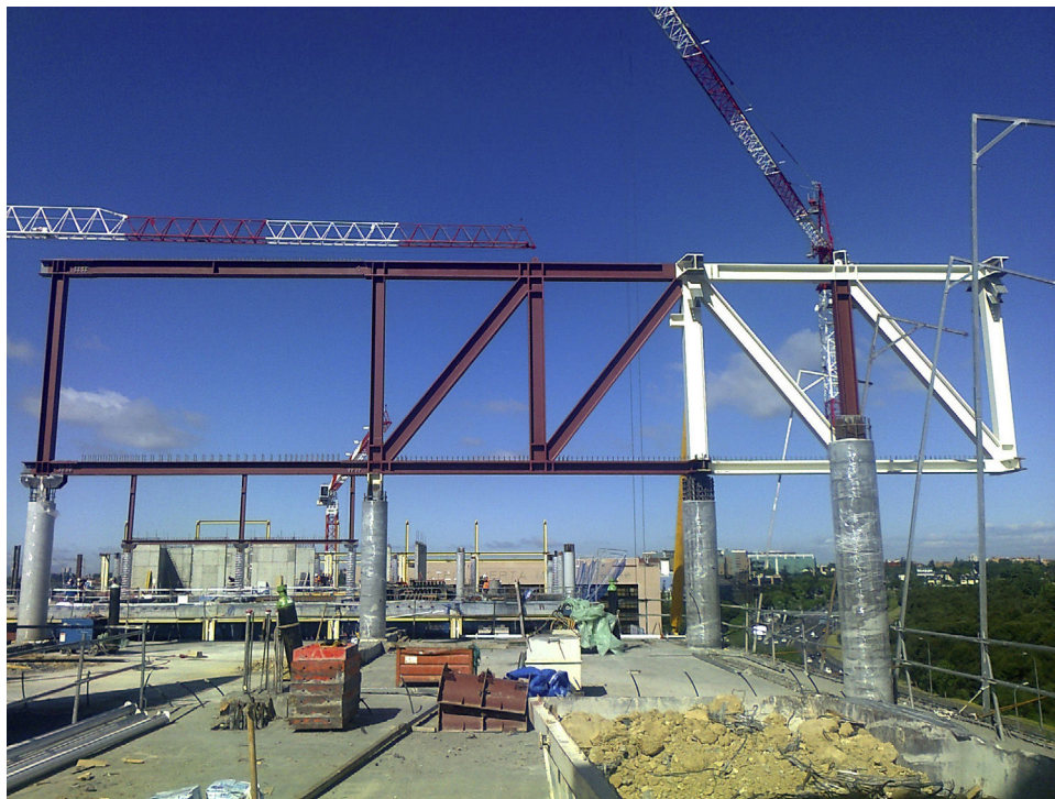
Figura 32. Montaje de celosías sobre soportes mixtos.
