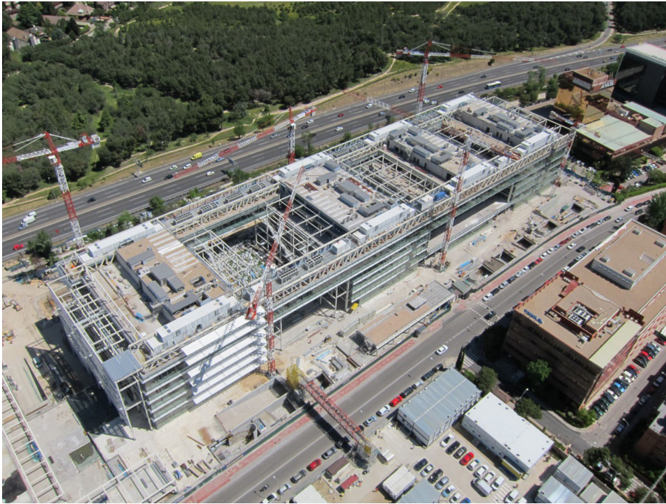
Figura 9. Vista general de la cubierta (mayo 2016).
