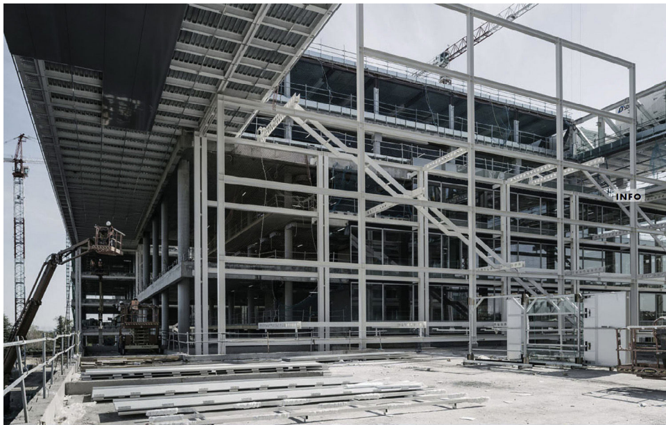
Figura 21. Estructura metálica exterior y escaleras de evacuación.
