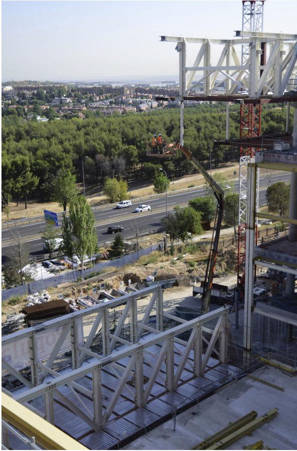
Figura 33. Puente norte pre-montado a la espera de izarse.
