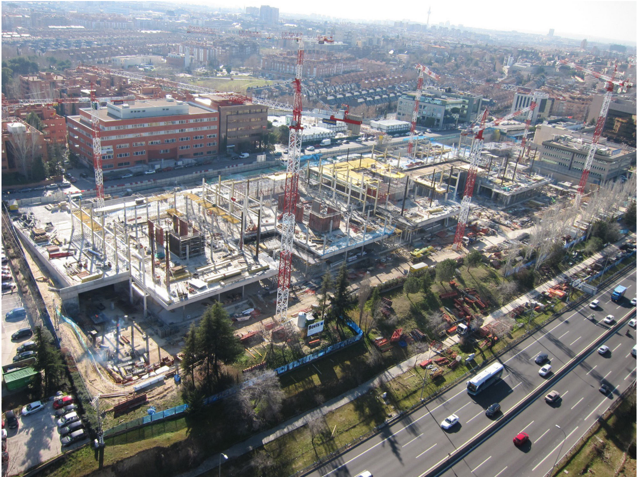
Figura 16. Ejecución de la estructura sobre rasante de forjados.
