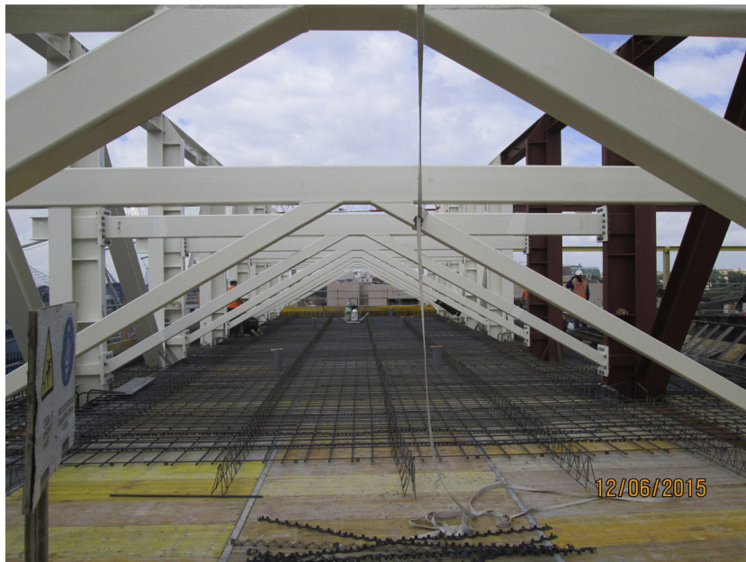
Figura 25. Bancadas integradas en la estructura de cubierta.
