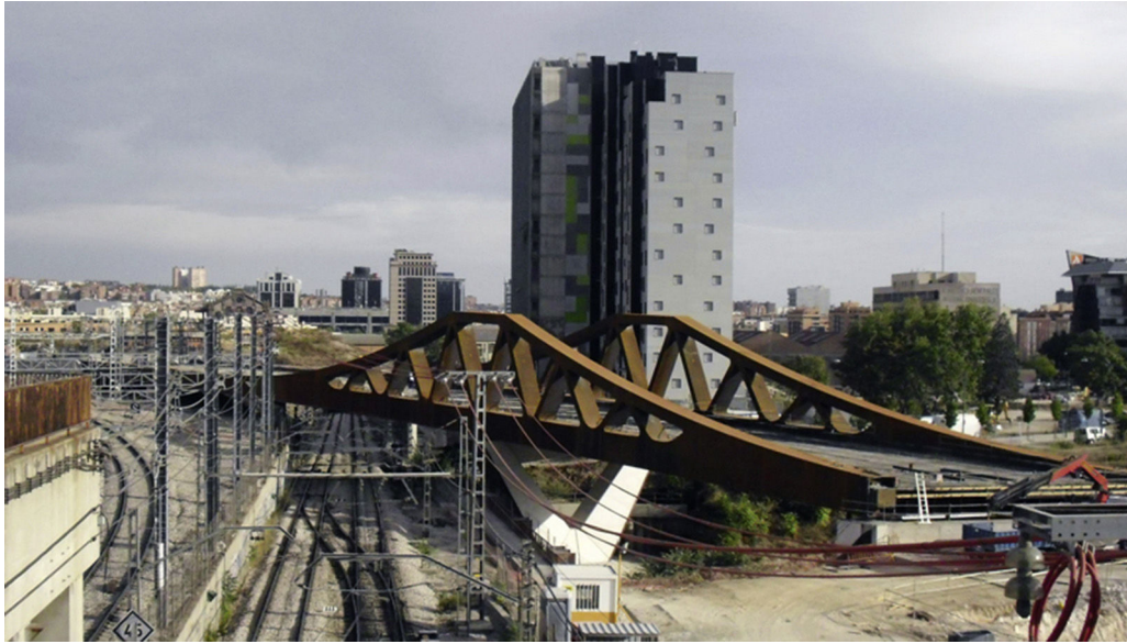
Figura 27. Viaducto de celosías peraltadas. Enlace ferroviario sobre la calle Comercio. MC2 Ingeniería (2010).
