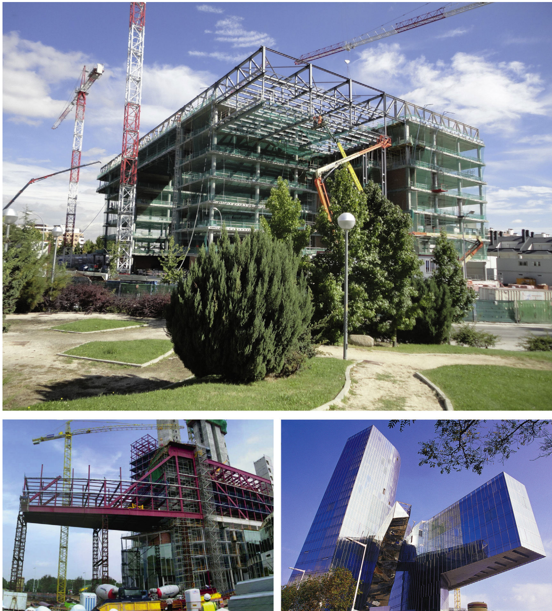
Figura 10. Edificio y cubierta del Centro de Proceso de Datos en fase de ejecución (arriba), edificio de la sede de Gas Natural en Barcelona (abajo).
