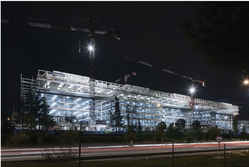
Figura 38. Imagen nocturna de las obras.
