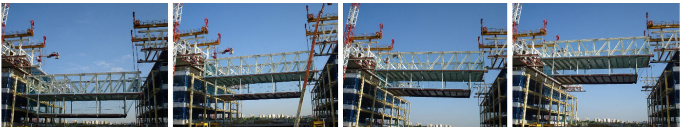
Figura 34. Izado de puente sur.
