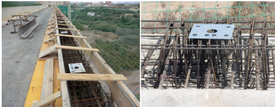
Figura 17. Ejecución de una solución concreta.
